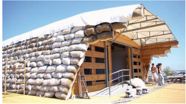
△ Figure 3. Recetas Urbanas, Aulario Trinchera, Málaga, 2005.
