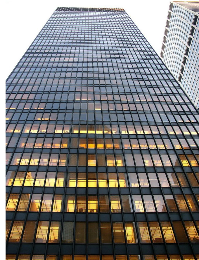
Imagen picada del edificio Seagram. Mies Van der Rohe, 1954-58.
